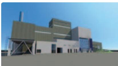
La plate-forme exploite un four qui génère de l'énergie par la combustion des déchets ; une chaudière libère cette énergie sous forme de vapeur à haute pression, qui alimente une turbine couplée à un alternateur ; la vapeur est ensuite refroidie et reprend son circuit vers la chaudière.
